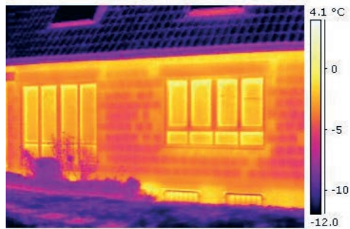
Thermografie einer monolithischen Außenwand
